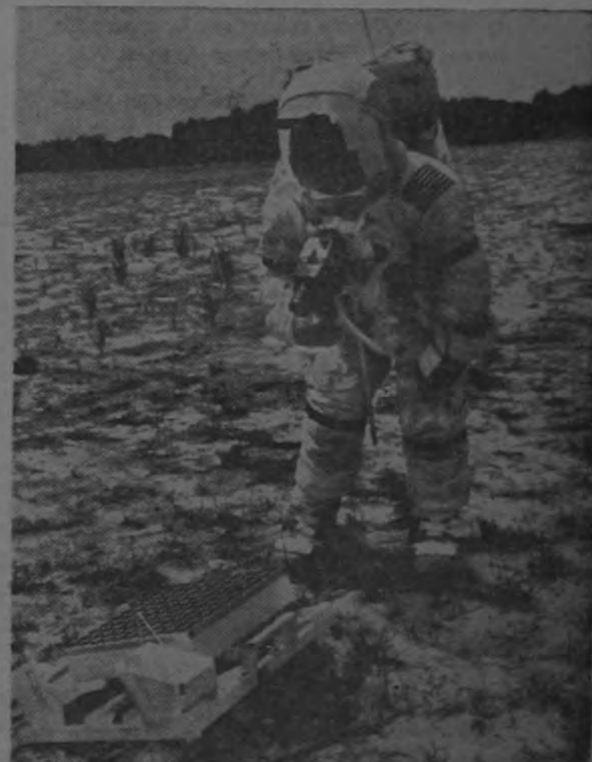
Shepard colocará en la Luna varios geofonos (foto), para detectar las vibraciones que producirán los 27 lunimotos. Otros aparatos científicos recogerán datos ambientales.
